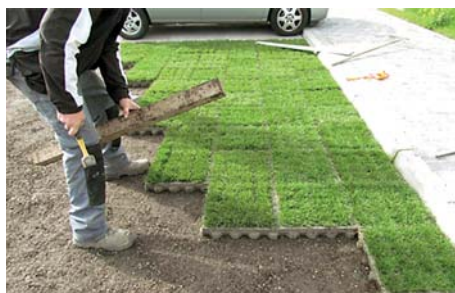
Umožnit zasakování vody a snížit přehřívání lze i na parkovištích. Realizace zatravněné zasakovací dlažby. Foto: Asio, spol. s r.o.
