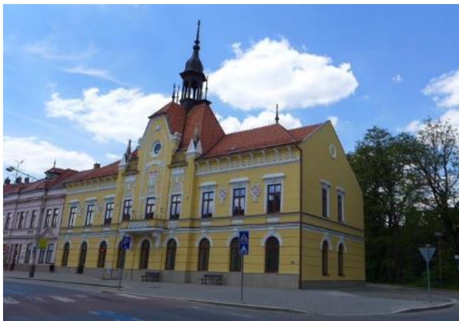
Obr. 1 – Budova staré radnice
