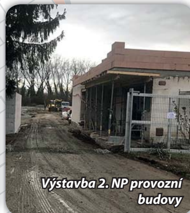
Základová deska budoucí strojovny
