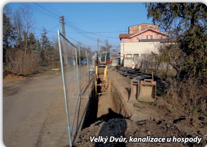
Velký Dvůr, kanalizace u hřiště
