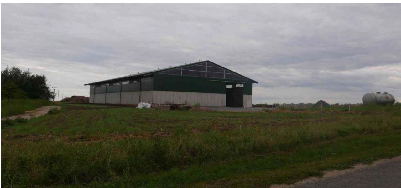
Obrázek č. 11: Plocha Z21, kde již probíhá výstavba.
