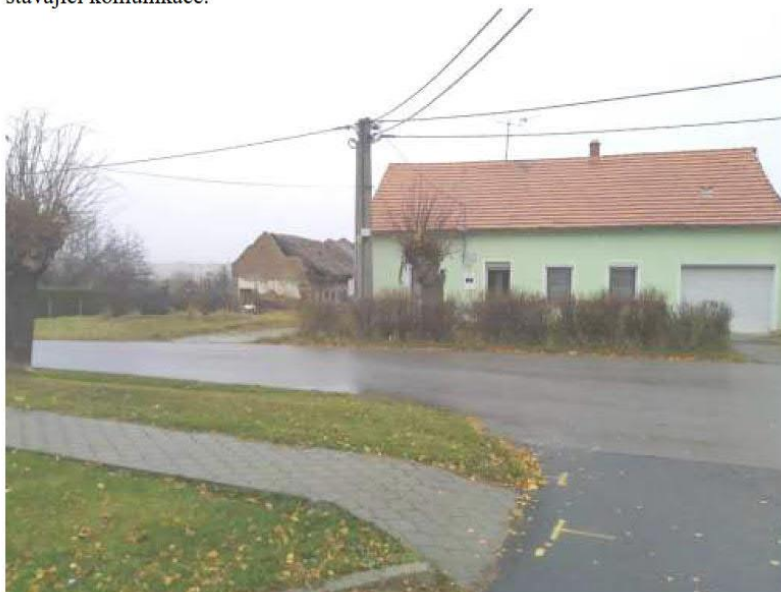
Foto 2: Součástí plochy BR 17 jsou i další chátrající objekty a navazující ruderální, neudržovaná vegetace.
