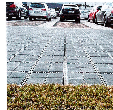
VODOPRIEPUSTNÝ POVRCH PARKOVÍSK zatravnňovacia dlažba prepúšťajúca dažďovú vodu na terén
