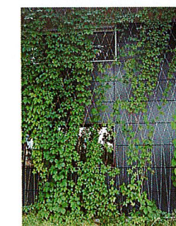
ZELENÁ FASÁDA popínavé rastliny na vertikálnej treláži z kovových laniek
